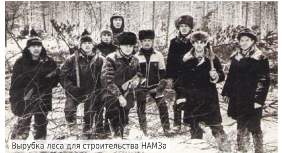
Вырубка леса для строительства НАМЗ
