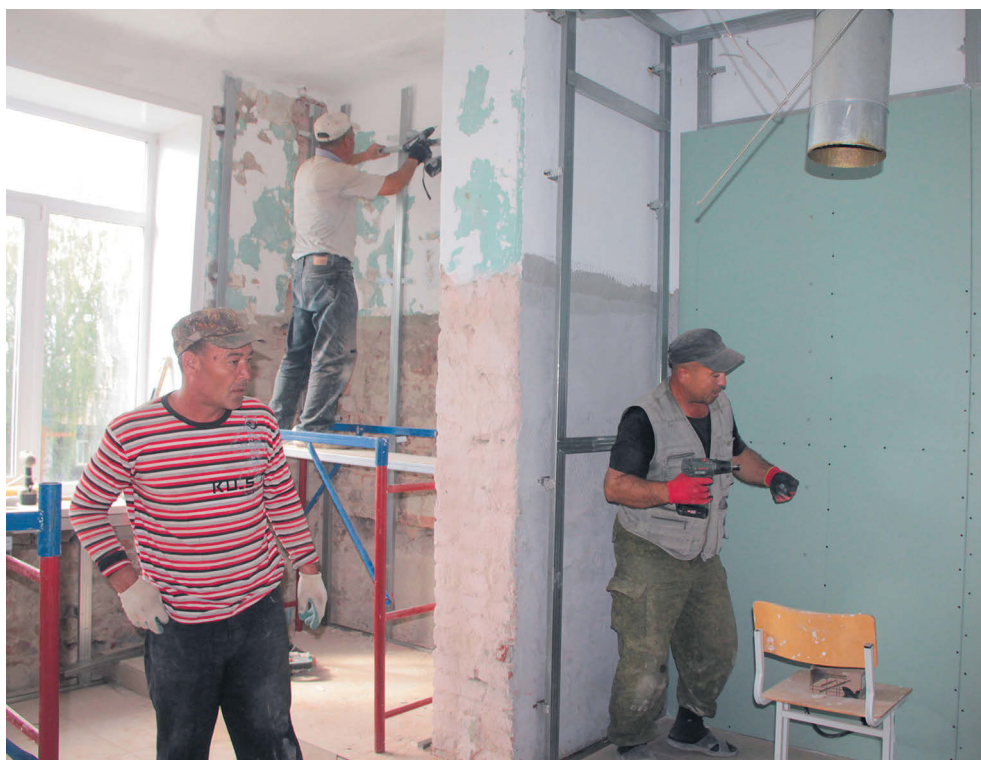
▲ Идет ремонт пищеблока в школе №5
