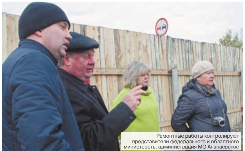
Капитальный ремонт плотины идет полным ходом
