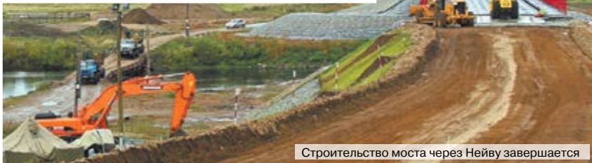
Строительство моста через Нейву завершается
