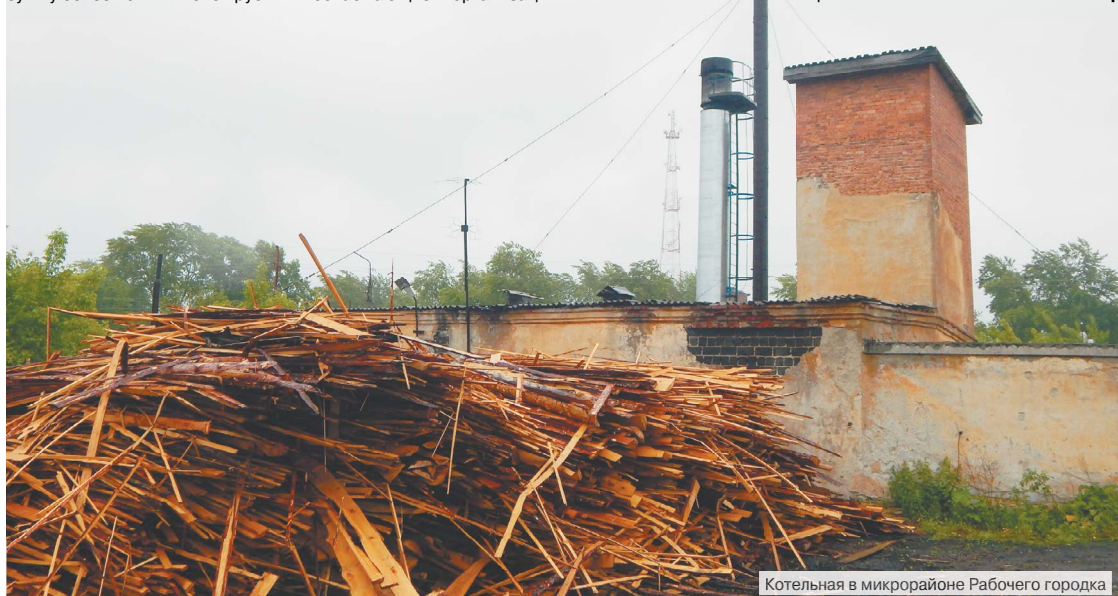
Котельная в микрорайоне Рабочего городка
