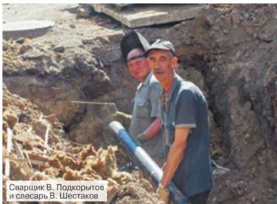
Замена теплотрассы во дворе дома ул. Пушкина, 61
