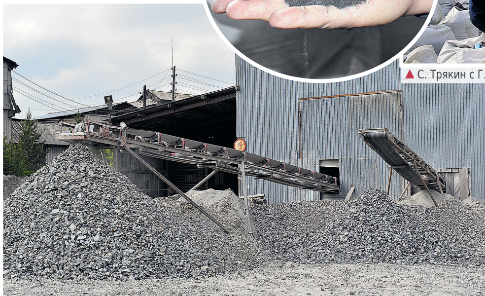
▲ На производственной площадке
