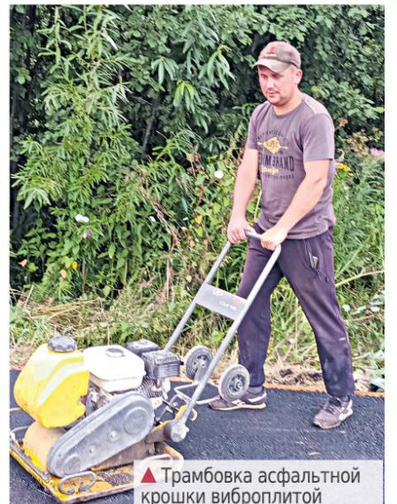
▲ Трамбовка асфальтовой крошки виброплитой
