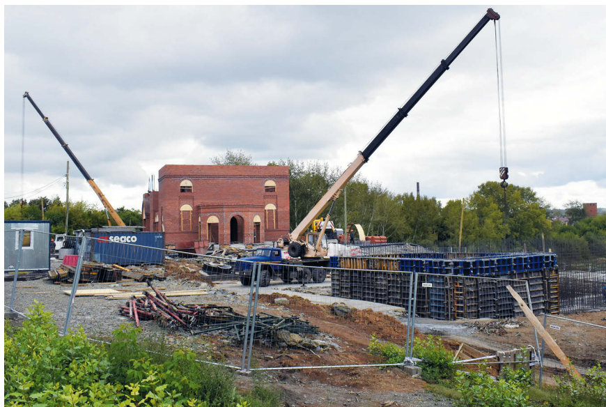
▲ Полным ходом идет возведение храма Александра Невского
