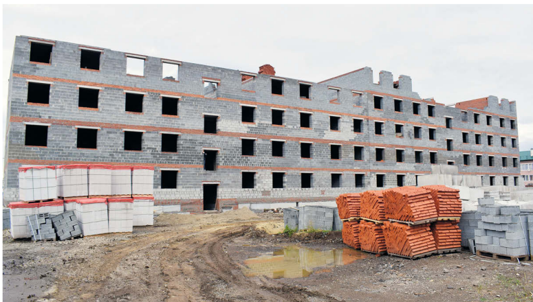
▲ Строительство нового многоквартирного дома в Северном микрорайоне
