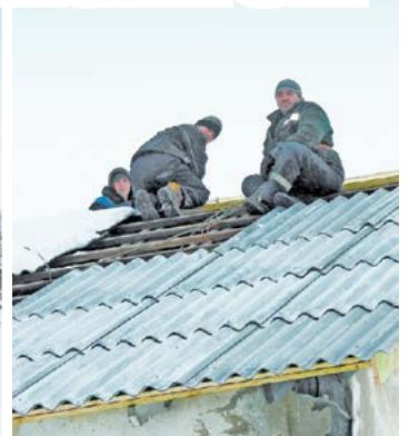
Ремонтные работы на крыше, а на дворе декабрь
