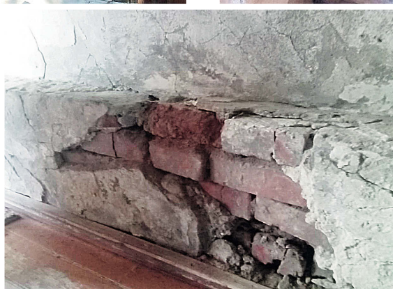
▲ Фундамент, который разваливается на глазах
