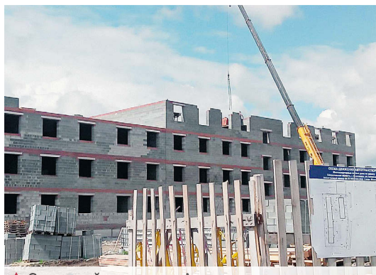
▲ Строящийся дом в г. Алапаевске | Снимок Юрия Калугина
