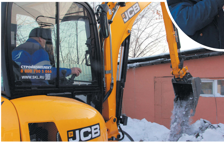
▲ Начало работ у дома по ул. Прокатчиков, 20. Февраль 2022 года
