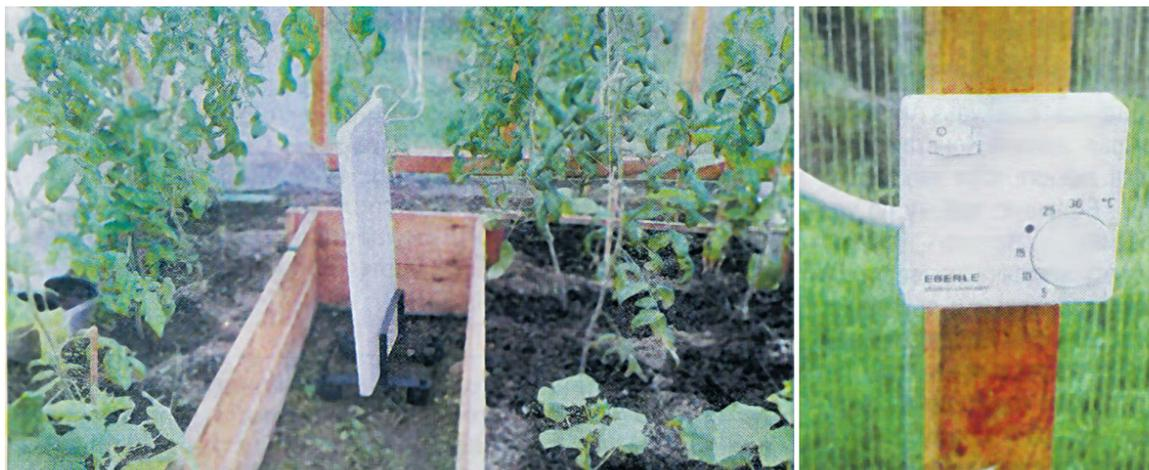
Один такой нагреватель может отапливать помещение с объёмом воздуха 18 кубических метров. На шестиметровую стандартную теплицу понадобится два таких нагревателя, их можно установить в разных её концах.
