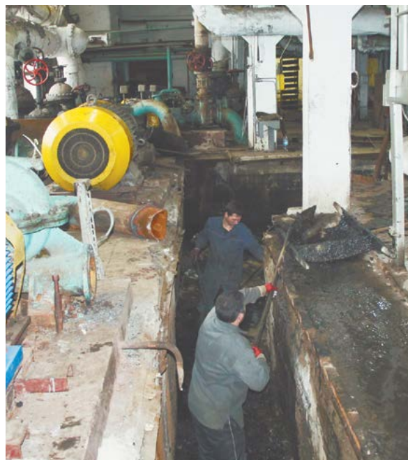
Работы на котельной АСЗ
