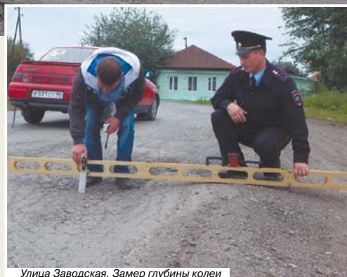
Улица Заводская. Замер глубины колеи
