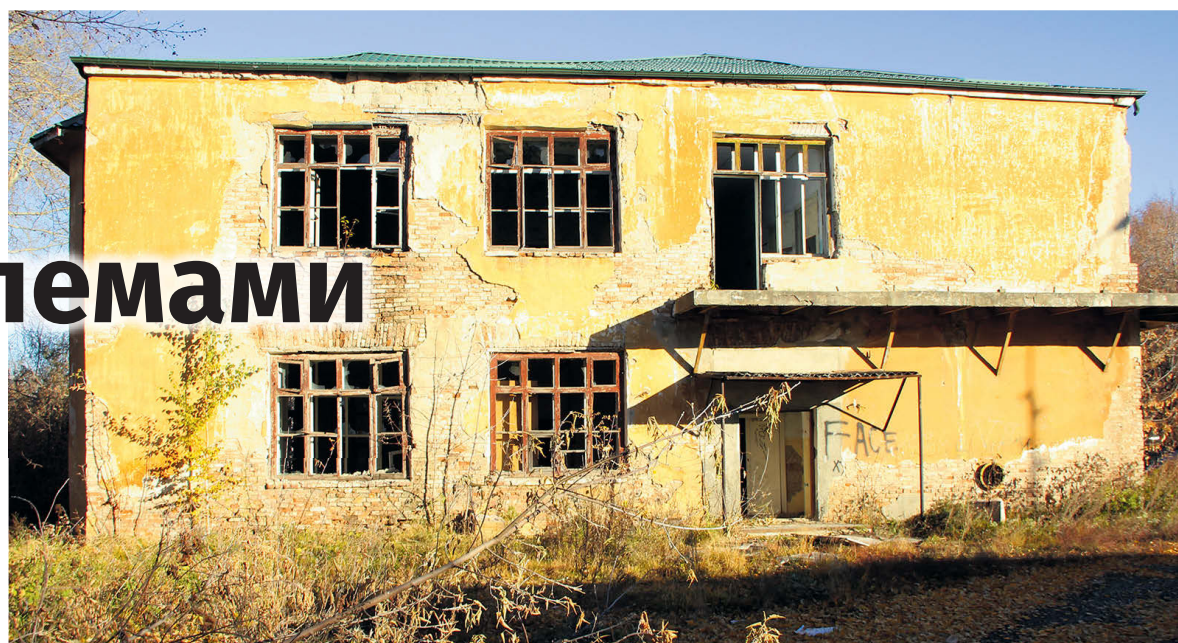
▲ Заброшенное здание Сангородка
