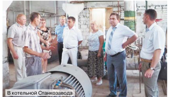
В котельной Станкозавода
